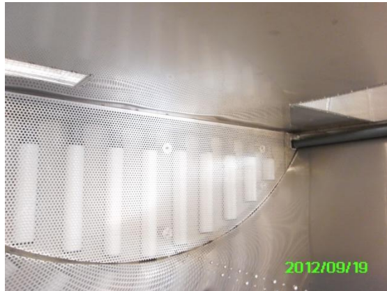
Eingebaute Rohrbelüfter
