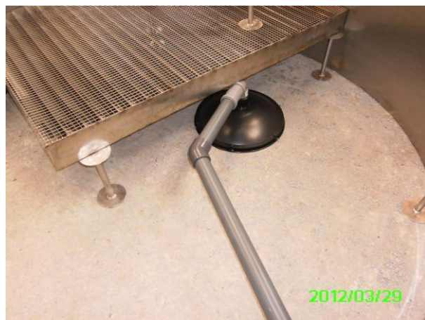
Bild 8: Hydrostatische Sedimentabsaugung
