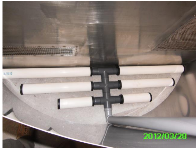
Bild 2: Nitrifikationsbelüfter
